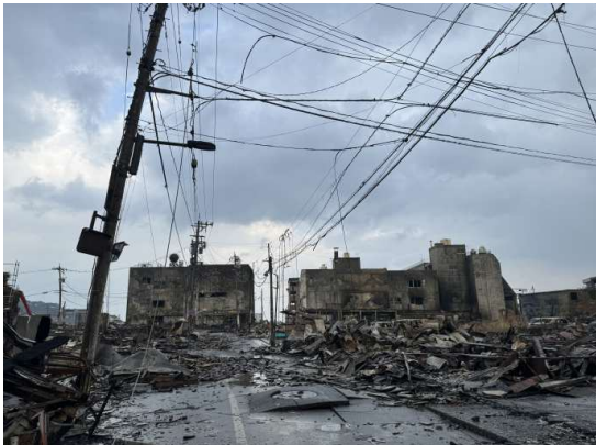
写真5 出火エリア付近から北方向を撮影
