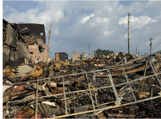
写真8 東西に延びる朝市通り（西部分）から北方向を撮影
